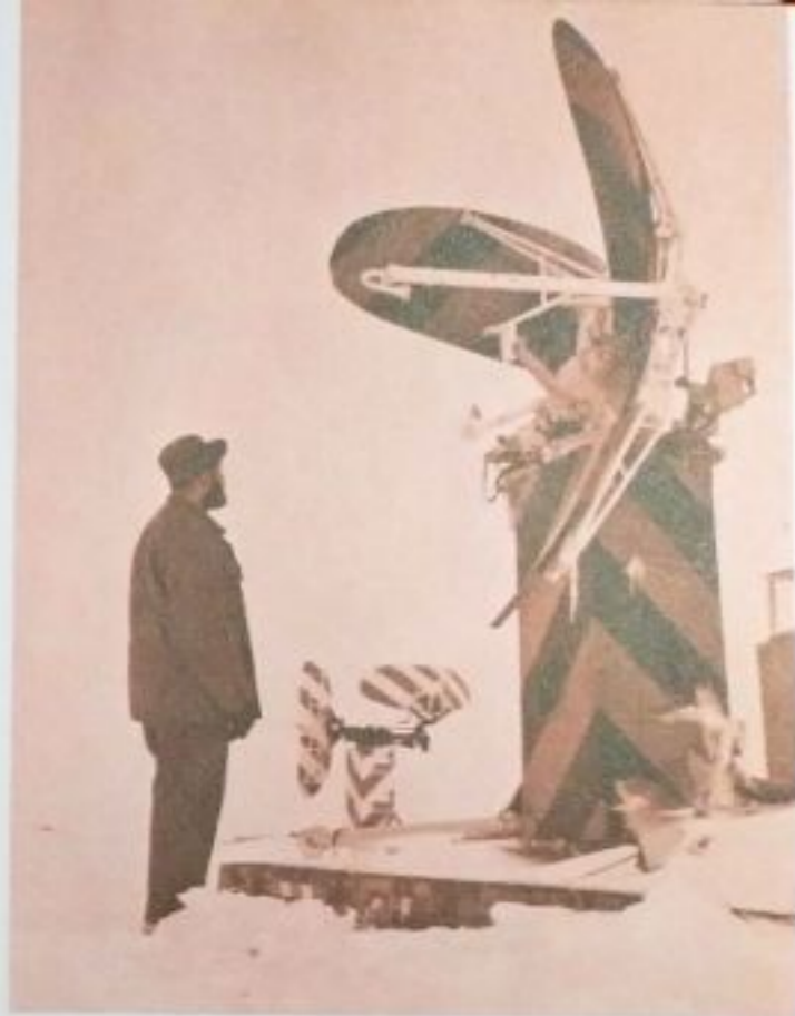
Williams Field GCA radar antennas.
